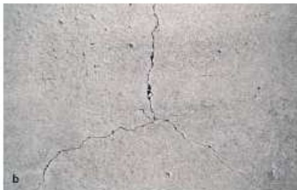
Figura 3: Ilustración que muestra que no hay desarrollo de agrietamiento en el hormigón que èste libre para contraerse (losa sobre rodillos). Estas son grietas típicas de contracción de una losa sobre terreno.
