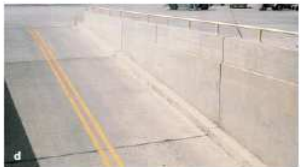
Figura 3: Ilustración que muestra que no hay desarrollo de agrietamiento en el hormigón que èste libre para contraerse (losa sobre rodillos). Estas son grietas típicas de contracción de una losa sobre terreno.
