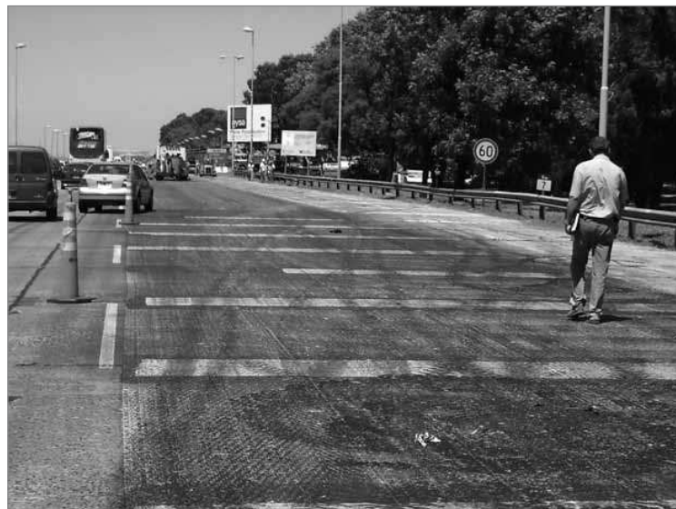
Foto 1. Colocación del S.A.M.I. con un geocompuesto en juntas.
