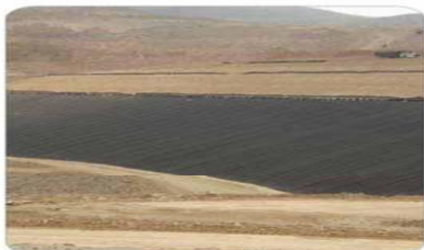
Figura N° 2: Embalse con pantalla impermeabilizante (Cerro Verde – Perú)
