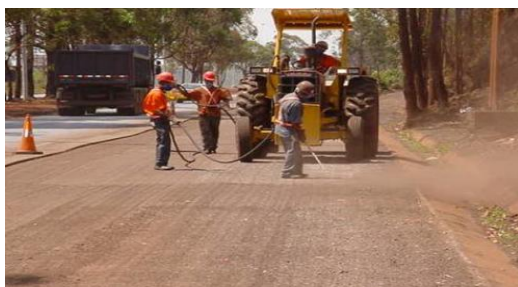
Figura N° 7: Repavimentación asfáltica a) Fresado de la superficie dejando irregularidades b) Extensión del Geotextil v paso de rodillo liso.
