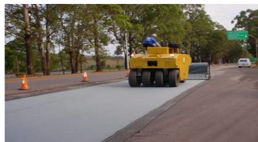
Figura N° 7: Repavimentación asfáltica a) Fresado de la superficie dejando irregularidades b) Extensión del Geotextil v paso de rodillo liso.
