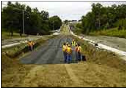
Figura 10 Colocación de Geotextil
