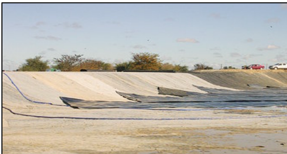
Figura 9 Geomembrana de Impermeabilización
