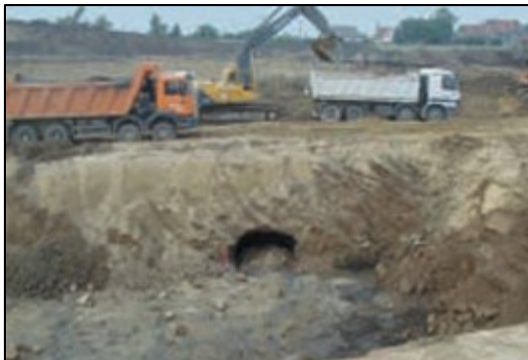
Figura 14 Refuerzo de Terraplén sobre cavidades
