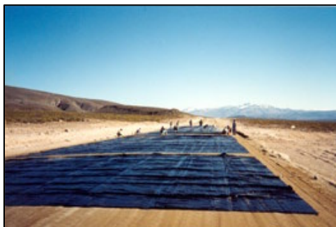
Figura 12 Geomembrana en subrasante vial
