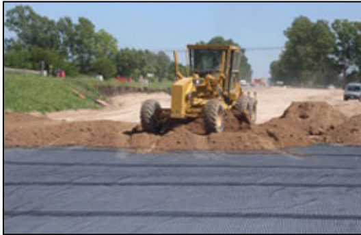
Figura 13 Refuerzo de Terraplén sobre suelos blandos
