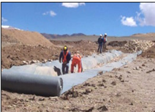
Figura 4 Geotextil uso drenes longitudinales
