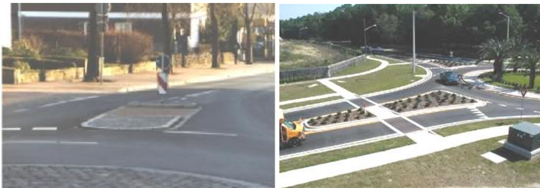
Figura 2 - Encauzador vehicular con rebaje peatonal
