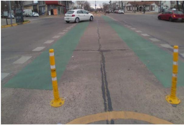
Imagen N°4: Ciclovía Diag. 73 e/ Boulevard 82 y calle 41
