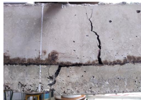
Figura 12 Viga con refuerzo de Geogrilla (GR) sección nuevamente ensayada
