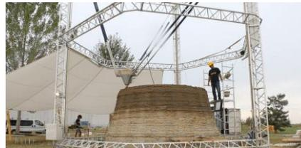
Figura 6. Impresora con boquilla de movilidad cartesiana dirigido por poleas móviles (las mismas suelen estar sostenidas por una estructura fija de tres o cuatro columnas).
