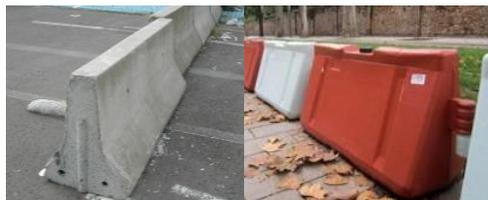
Figuras 25-26. Barrera permanente de hormigón y barrera provisoria de plástico.
