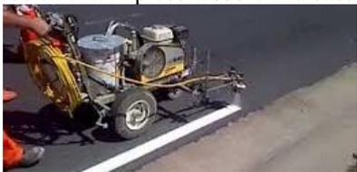
Figura 3. Equipo de demarcación vial.
