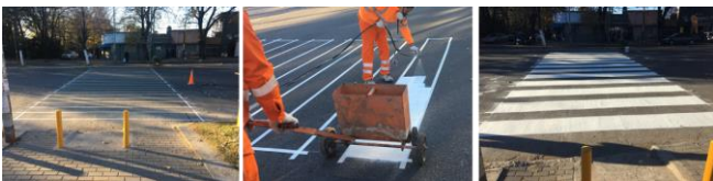
Figura 2. Aplicación de pintura en senda peatonal.
