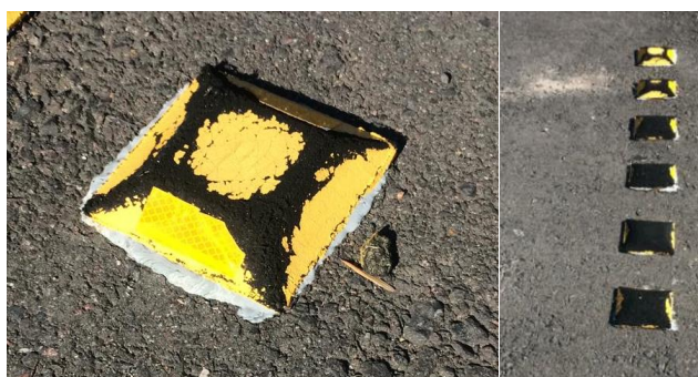
Imagen 12: vista de las tachas después de 6 meses de colocación
