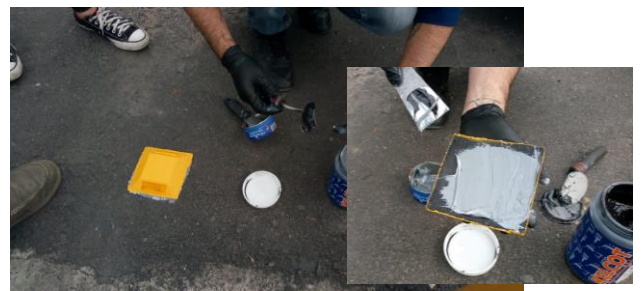
Imagen 10: Pegamento de las tachas en pavimento
