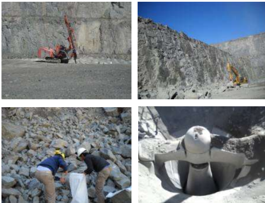
Macizo rocoso. Perforaciones para voladura. Trituración primaria de cono. Tomado de muestras.
