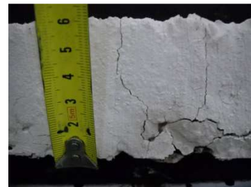
Figura 8: Fin ensayo minuto 60', h fisura = 50mm
