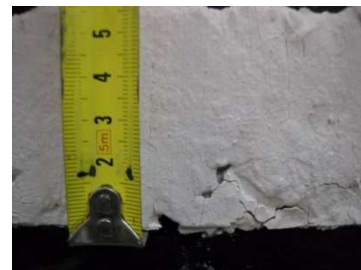
Figura 4: 1º parada minuto 10', h fisura = 12mm
