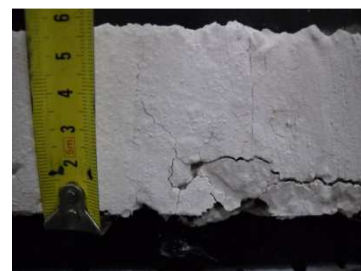
Figura 6: 3º parada minuto 30', h fisura = 35mm
