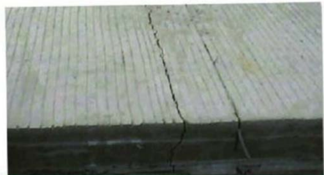
Figura 2. Junta aserrada demasiado tarde
