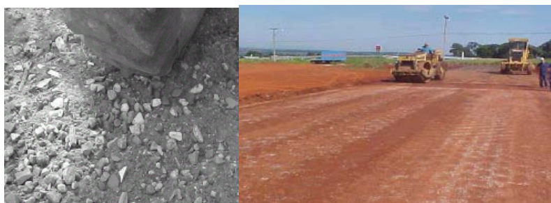
Foto N° 5 Estabilizado visto de cerca. Obra terminada de compactar con el pata de cabra
