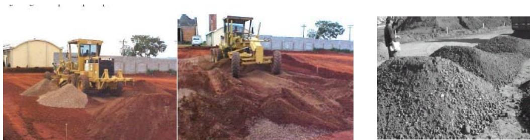
Foto N° 4 Preparación de agregados
