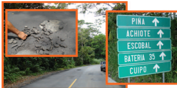
Detalle de desprendimientos prematuros de vía principal zona exclusiva Atlántico canal Panamá
