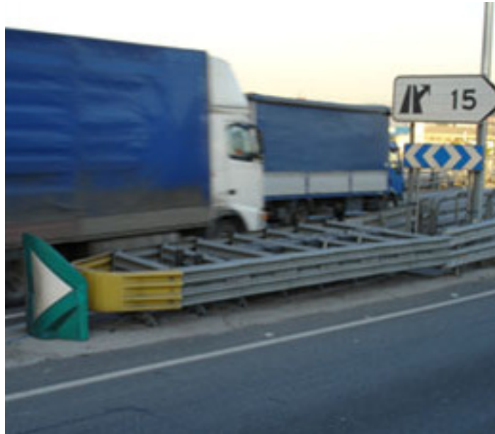
Foto N°1: Atenuador de impacto
