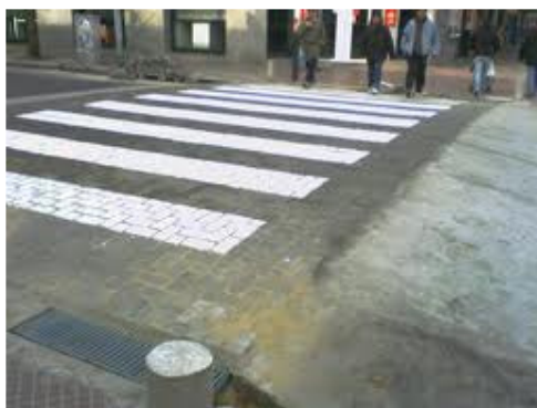
Foto 4: Señalización horizontal en paso peatonal
