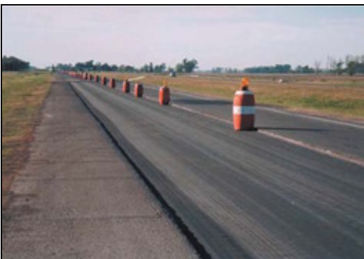
Figura 9 Geotextil extendido y con ambos riegos aplicados.
