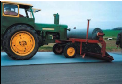
Figura 7 Instalación del geotextil con un bastidor de empuje.
