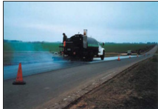
Figura 8 Segundo riego de cemento asfáltico en caliente
