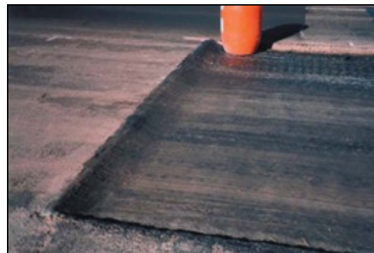
Figura 10 Se observa la flexibilidad del geotextil que le permite copiar las irregularidades del fresado.
