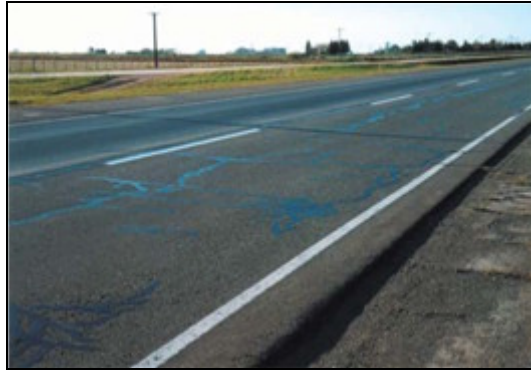
Figura 6 Pavimento existente previo al fresado.
