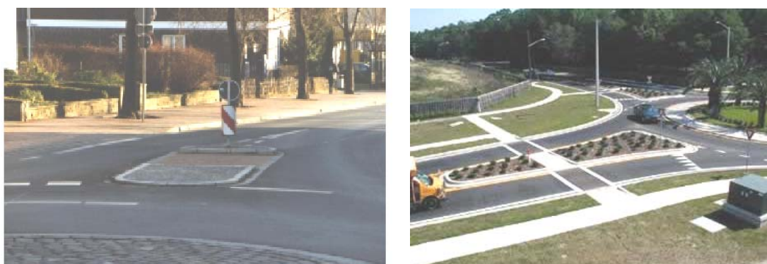
Figura 2. Encauzador vehicular con rebaje peatonal
